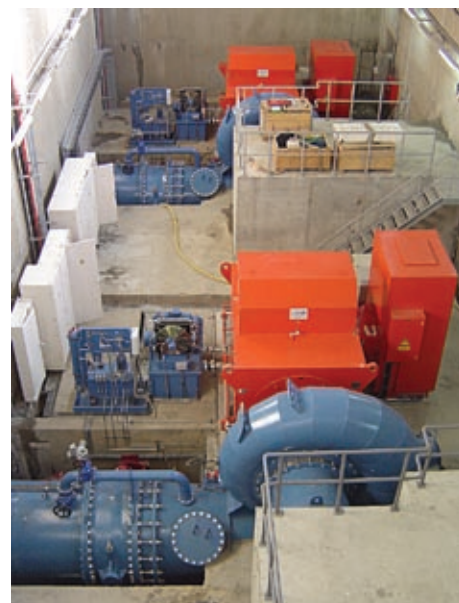
Links der neue Generator für das Alstom-Kraftwerk in Rheinfelden vor der Auslieferung, rechts die beiden Maschinen für Kulp IV (Türkei) während der Installation.
